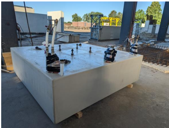
Abbildung 5 Vorgefertigter Fundamentblock für die Energiesäule
